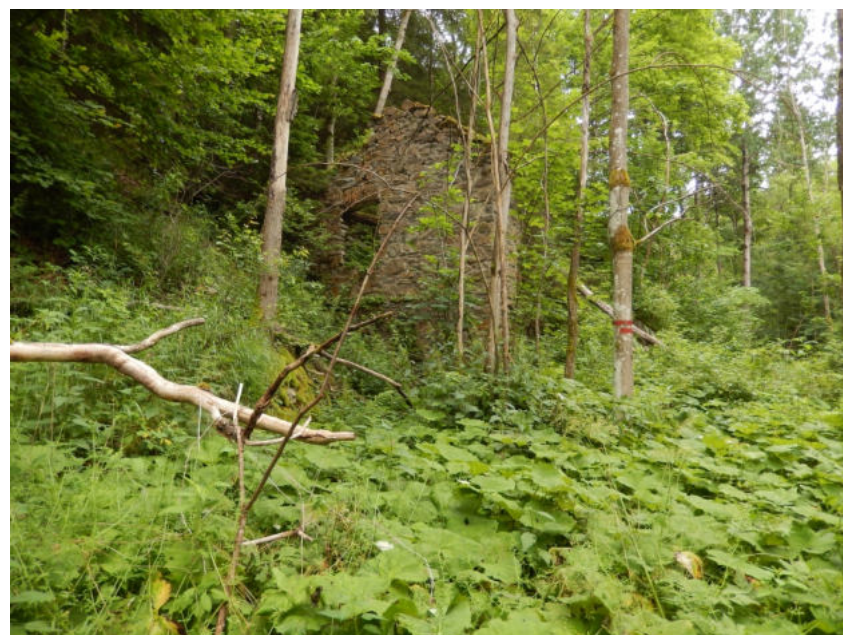
Foto 12. Zbytek kamenné stavby v malém segmentu PR v jihovýchodním okraji lokality.
