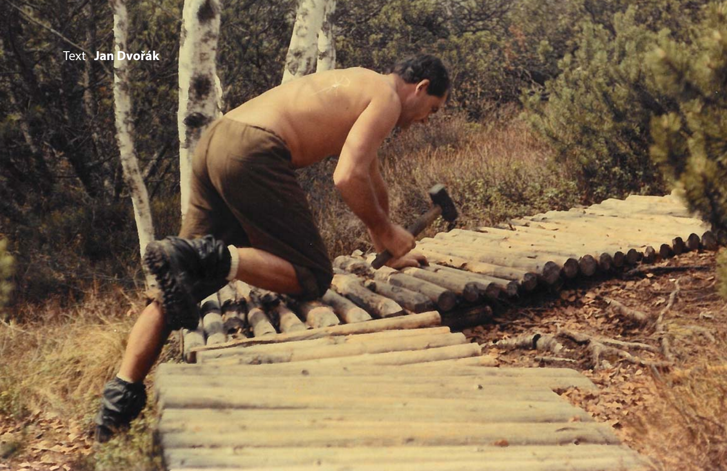
S vyhlášením Národního parku Šumava byla oprava poválek a dalších technických zařízení vzhledem k vyšší návštěvnosti prvotní. Foto: Štefan Labaj
