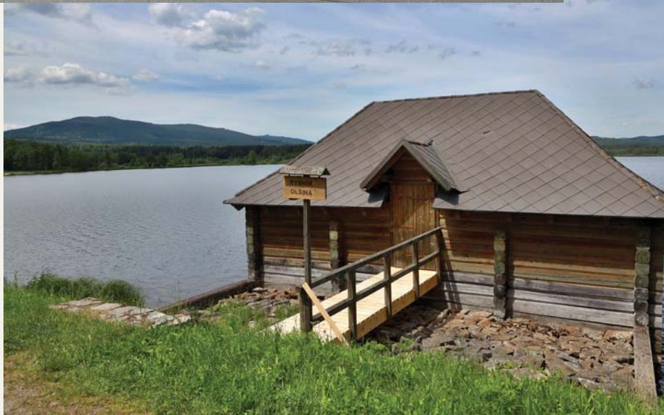
Hrázní domek ukrývá stavidla rybníka.
