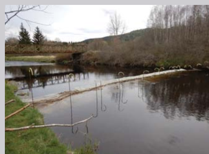
Provizorní mechanická zábrana v profilu Pěkná, kde se plánuje vybudování kombinované elektricko - mechanické protimigrační bariéry.
