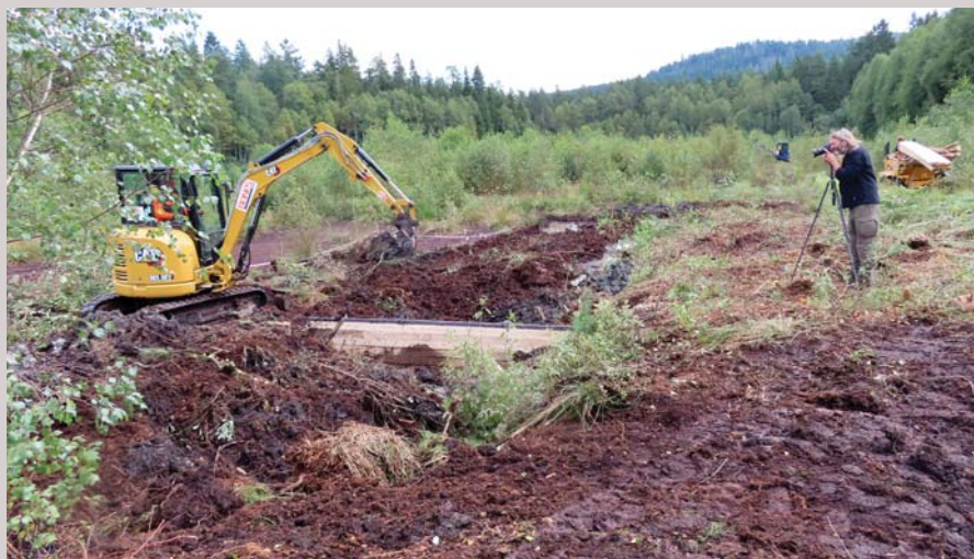
Stavba hráze na jednom z hlavních odvodňovacích kanálů – u velkých kanálů je kromě zablokování dřevěnými hrázemi velmi důležité jejich zasypání dostupným materiálem.
