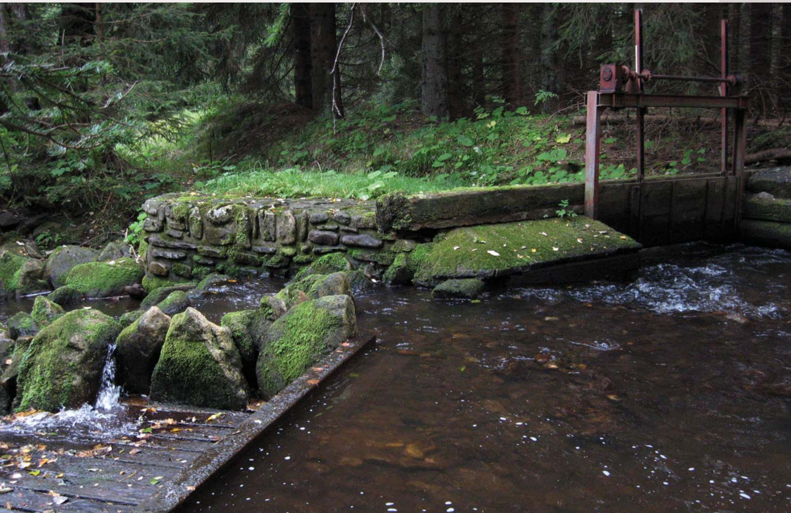
Těleso jezu s odběrem vody pro elektrárnu.
