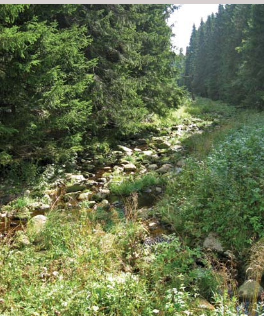
Tok řeky pod jezovým tělesem s odběrem vody pro elektrárnu.
