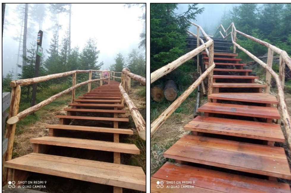
Obrázek 53 Oprava přístupové cesty na vrchol v NPR Boubínský prales.
